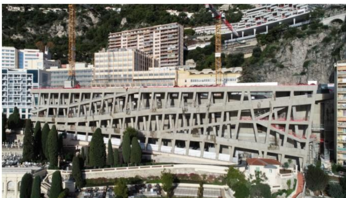
L'état des travaux en décembre dernier, au fond l'immeuble Le Bel Air © Direction de la communication
