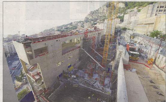
L'ouvrage d'art, visible du bas de la Principauté, est la partie basse de soutènement de tout l'hôpital. Un parking sera construit dans le trou où est stocké actuellement le matériel de chantier. Au-dessus viendront se greffer les bâtiments purement hospitaliers.
